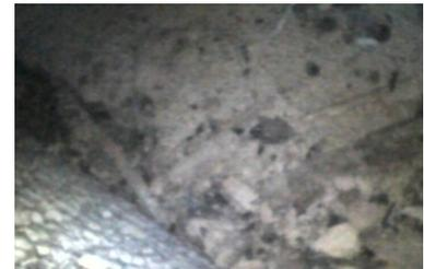
Abb 15 Mäusekot in dem Zwischenboden. Diese sind kompakter und stumpfer als Kotkrümel von Fledermäusen (Ansicht mit der Endoskopkamera).
