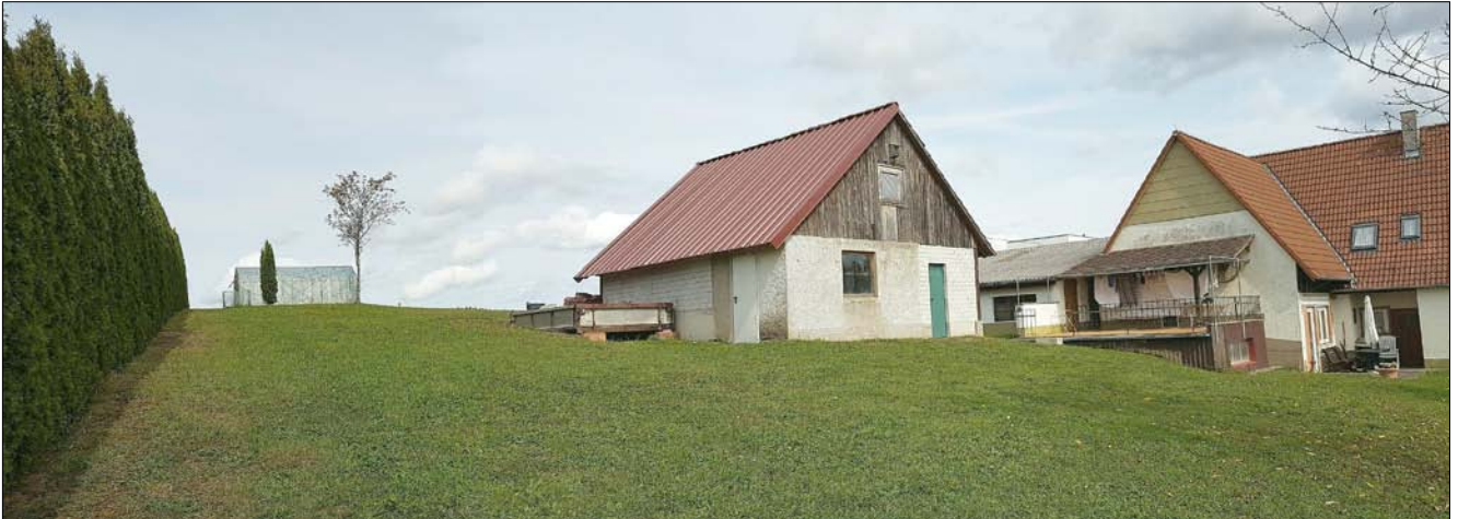
Plangebiet mit Bestandsbebauung im Süden des Gebiets
