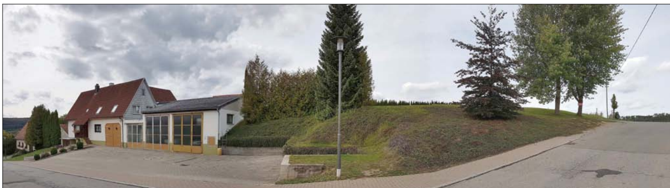
Ansicht aus Osten von der Steigstraße auf das Plangebiet mit vorhandener Bebauung und Grünflächen
