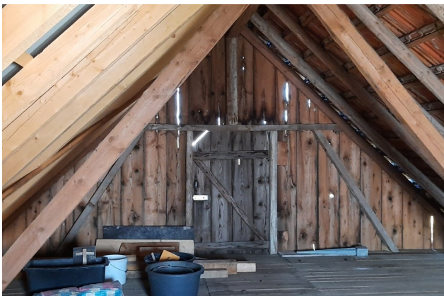
Abb. 18: Dachstuhl des Schuppengebäudes (Blick in nördliche Richtung).
