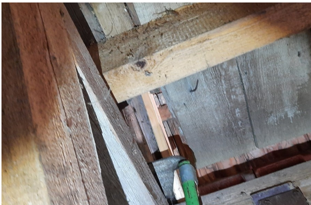
Abb. 20: Balkenstruktur im Schuppen.
