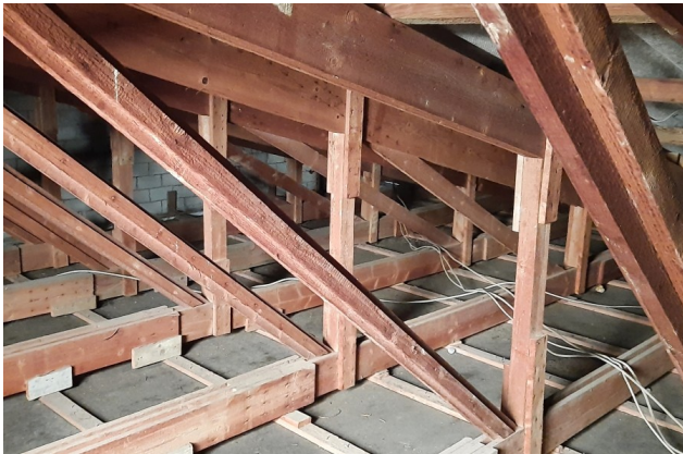
Abb. 16: Balkenstruktur im Dachboden über der Werkstatt.
