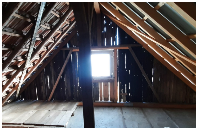
Abb. 19: Dachstuhl des Schuppengebäudes (Blick in südliche Richtung).
