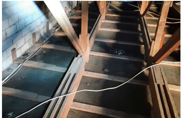
Abb. 17: In diesem hellen Dachraum bestehen so gut wie keine für Fledermäuse nutzbare Spaltenstrukturen.
