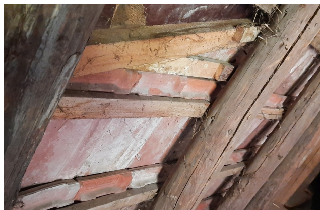
Abb. 12: Bereich des Dachbodens, welcher nicht isoliert ist und damit potenzielle Spaltenquartiere aufweist.
