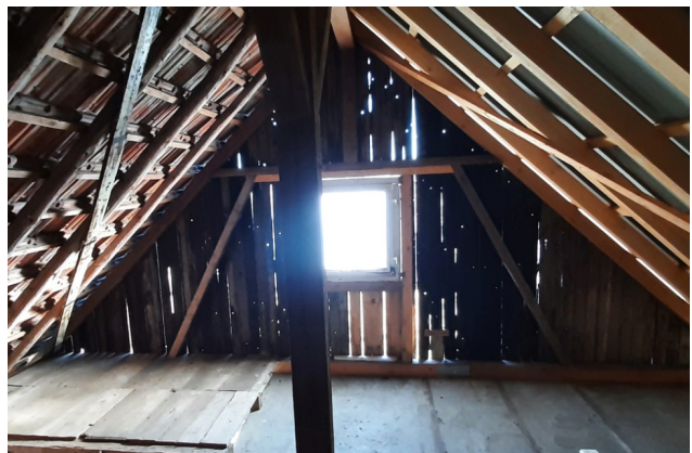
Abb. 19: Dachstuhl des Schuppengebäudes (Blick in südliche Richtung).
