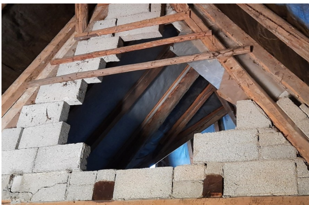
Abb. 11: Durchlass zwischen Dachboden und dem Bereich der Scheune.
