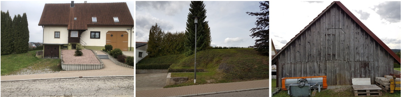
Abb. 27: Mauern sind zumeist vermörtelt bzw. Betonformsteine ohne Fugen versetzt worden. Baumaterialien wurden nur kurzzeitig abgelagert
