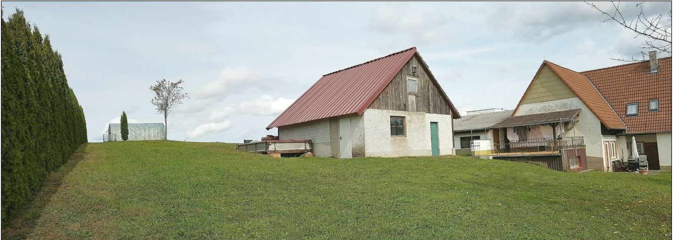
Plangebiet mit Bestandsbebauung im Süden des Gebiets
