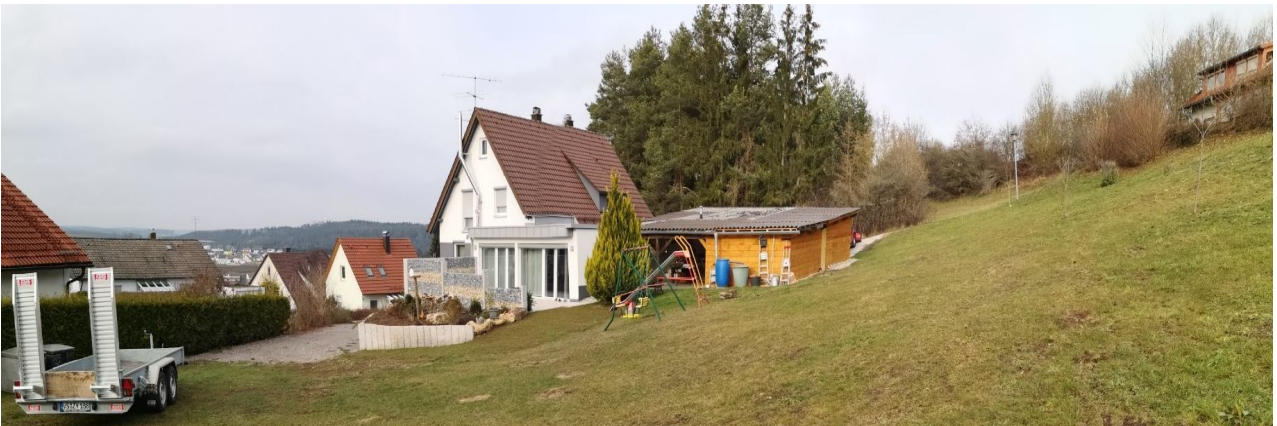
Abb. 4: Hangabwicklung in Westexposition von Süden betrachtet.
