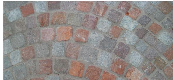
Kleinpflaster aus Granit-Porphyr-Mischung
