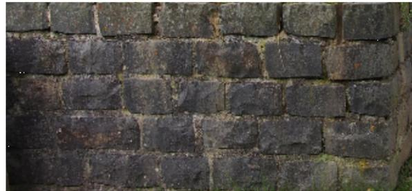
Mauer analog zum Bestand aus Basalt
