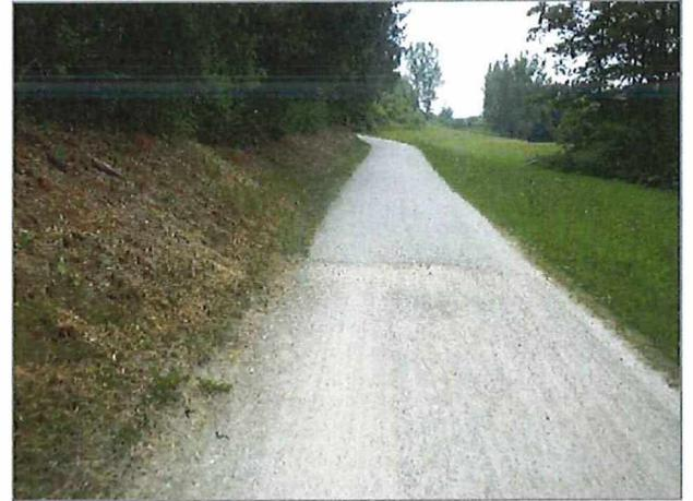
Begründung: Wassergebundene Oberflächen verschlechtern die Fahreigenschaften (u.a. höherer Kraftaufwand). Durch schlechte Griffigkeit steigt die Unfallgefahr. Dies gilt insbesondere bei oder nach Niederschlägen. Räumen im Winter ist nicht möglich. Erhöhter Verschleiß am Fahrrad / Verschmutzung der Kleidung.
