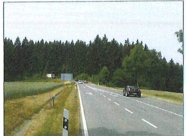
Begründung: Die Führung auf der Fahrbahn ist aufgrund der geringen Fahrbahnbreite, der hohen Kfz-Geschwindigkeiten, der Kurvigkeit, der Topografie und der hohen Kfz-Verkehrsbelastung nur bedingt für den Radverkehr geeignet.
