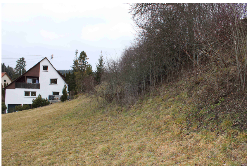
Bild 3: Böschung Blickrichtung West
