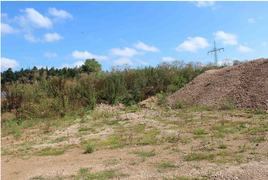
Abbildung 5: Blick von der Fläche Richtung Norden auf den bereits geschütteten Wall
